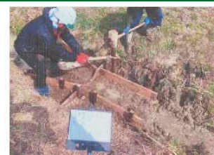
皿池用水路 ビオトープ整備 (高砂市)
